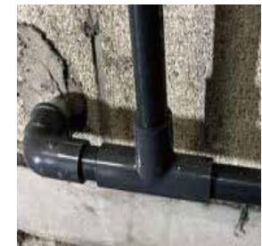
古い配管を残した状態にすると本体の寿命の20年を待たずに漏水や水圧不足が起こり、修理を再度依頼する確率が高くなります。また古い配管を残して施工してしまう業者に対して、注意を促すマンションの管理組合も存在します。
